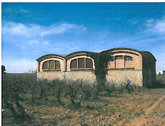
Fotografia 5: Construcció agrícola d'interès situada dins de l'àmbit d'estudi SUD-18 al municipi d'Olèrdola (Font: Elaboració pròpia. Any 2008)
